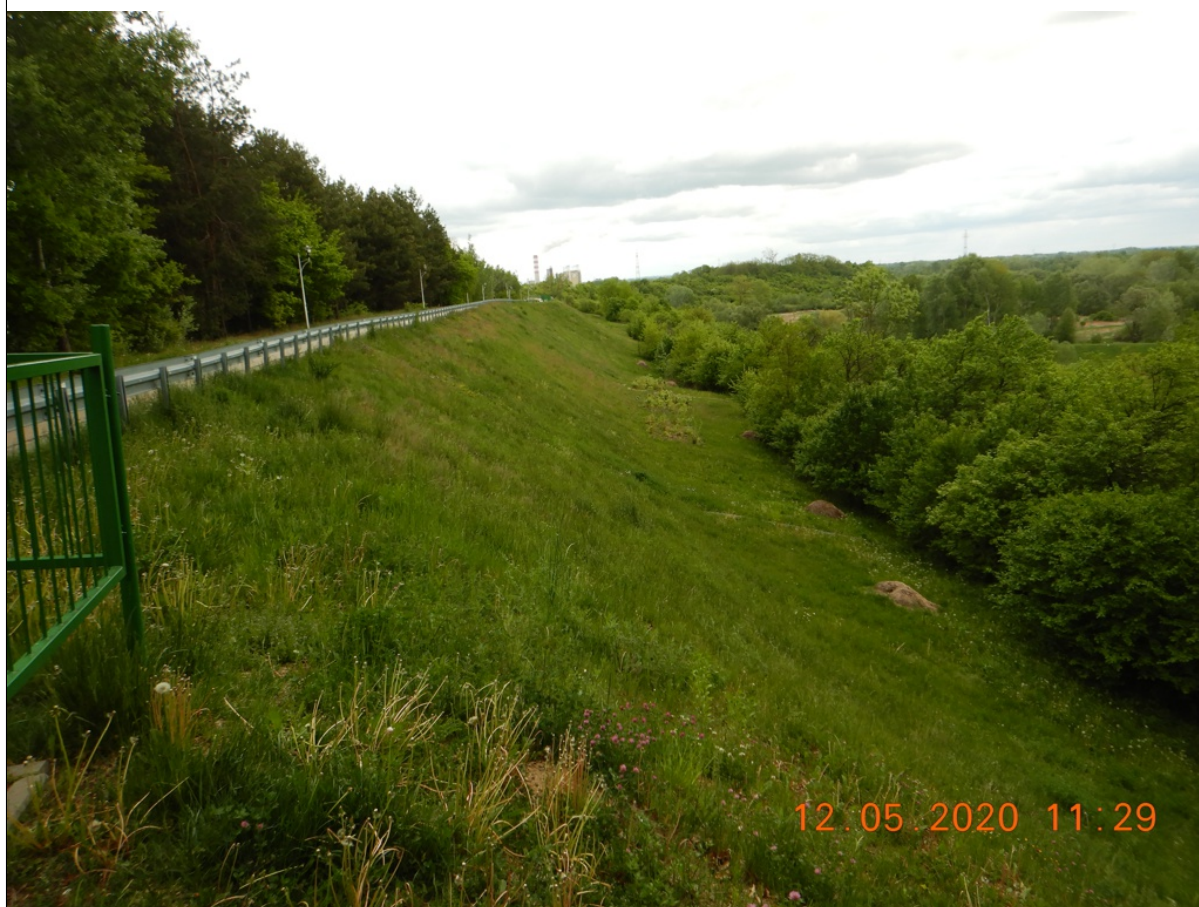
Zabezpieczona skarpa osuwiska (maj 2020)
